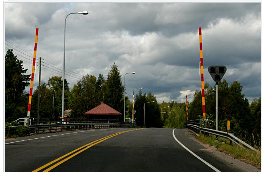
Visuveden avattava silta Ruovedellä. Silta mainitaan pohjoismaiden pisimmäksi yksilaakeriseksi kääntösillaksi.
