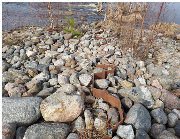
Kuva 6.5. Pohjapatorakenne järven luusuassa rannalta kuvattuna. Oikealla näkyvä pohjapadon läpi kulkevat ponttiseinärakenne.
