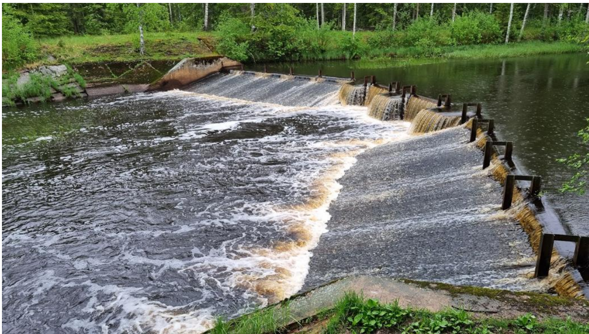
Kuva 6.8. Niemijärven betonirakenteinen pohjapato Siikaisissa.
