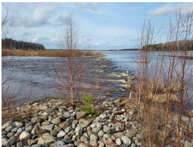
Kuva 6.5. Pohjapatorakenne järven luusuassa rannalta kuvattuna. Oikealla näkyvä pohjapadon läpi kulkevat ponttiseinärakenne.
